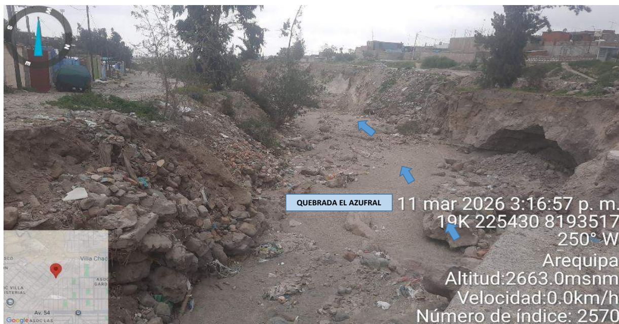
IMAGEN 02: EN ESTE TRAMO SE OBSERVA QUE EN AMBAS MÁRGENES DE LA QUEBRADA AZUFRAL, SUS TALUDES SE ENCUENTRAN SOCAVADOS, SIN PROTECCIÓN Y SU CAUCE SE ENCUENTRA COLMATADO.
